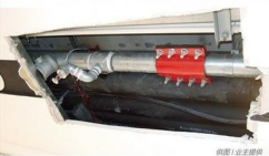
万科天地三期2号楼二单元二层 消防管爆裂时漏水的情况
